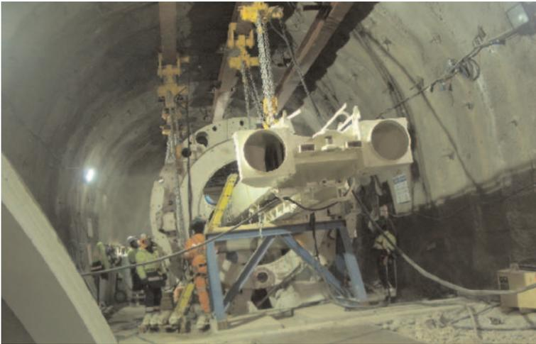
Fig. 5. Montaje de tuneladora en caverna.
