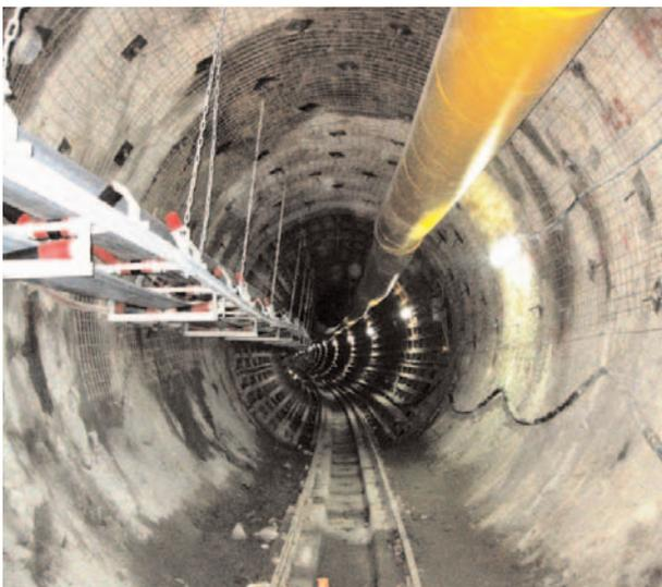
Figura 19. Paso de sostenimiento tipo 2 a tipo 5.
