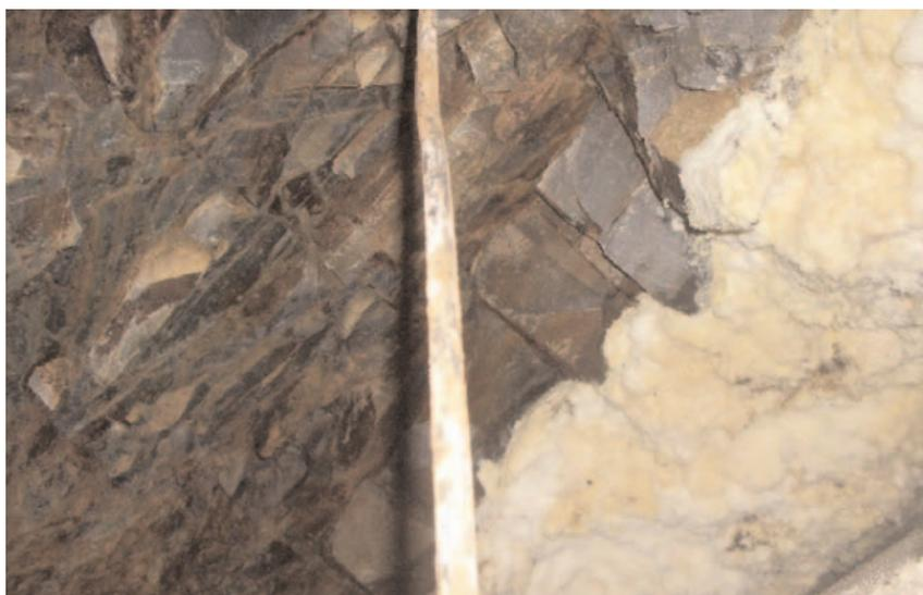
Fig. 16 - Relleno de una cavidad en el frente.
