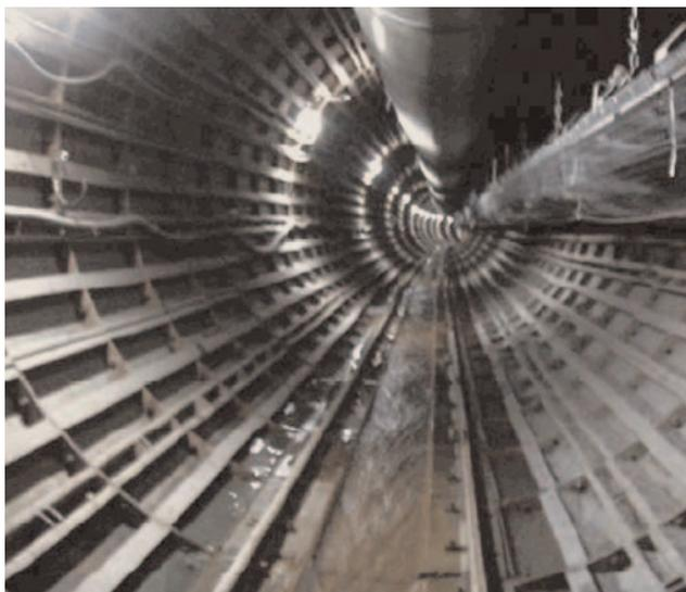
Fig. 12. Anillo metálico de sostenimiento para el tipo SC4 y SC5 (2).
